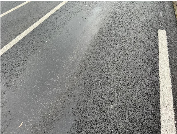
Figuur 3 Vetslaan in SMA
